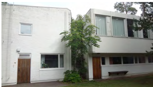
fig10 玄関を回り込み建物の側面へ
